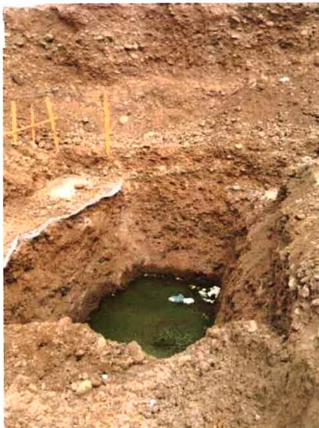
Foto 8: Excavación con agua superficial en sector poniente de la obra
