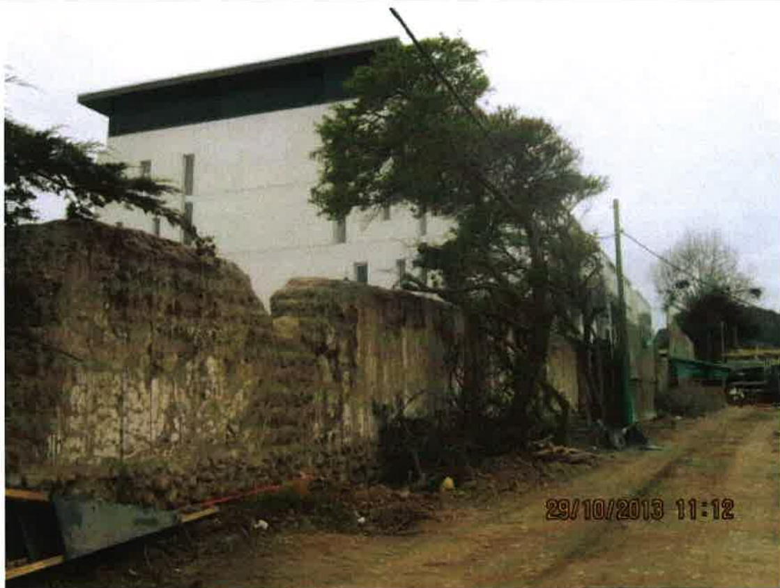
Foto 12: Sector habitacional norte, en desprotección contra el ruido y aledaña a vía de circulación interior de la obra
