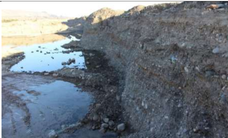
Fotografía N° 2. Registro capturado en visita a terreno de fecha 14 de mayo de 2021 evidenciando excavación en zona informada por la empresa como no explotada.
