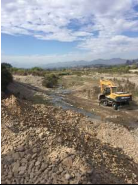
Fotografía N° 5. Remoción de material pétreo sector aguas arriba Puente Altovalsol.
