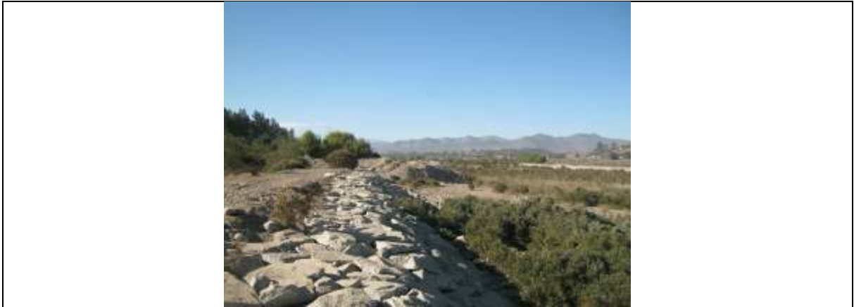
Fotografía N° 9. Acopio de áridos sector aguas arriba Puente Altovalsol, próximo a pretil de rocas.
