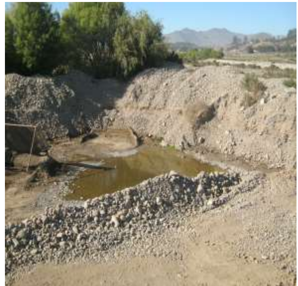
Fotografía N° 8. Procesamiento de áridos sector aguas arriba Puente Altovalsol.
