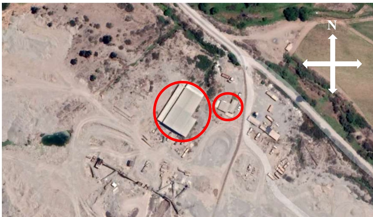
Fotografía N° 2. Captura de imagen satelital disponible en plataforma de acceso público Google Earth de fecha 7 de enero de 2019, evidenciando construcciones no informadas en el expediente asociado al permiso de extracción mediante decreto N° 1.120, de 2019, a la empresa Áridos Lin Limitada.
