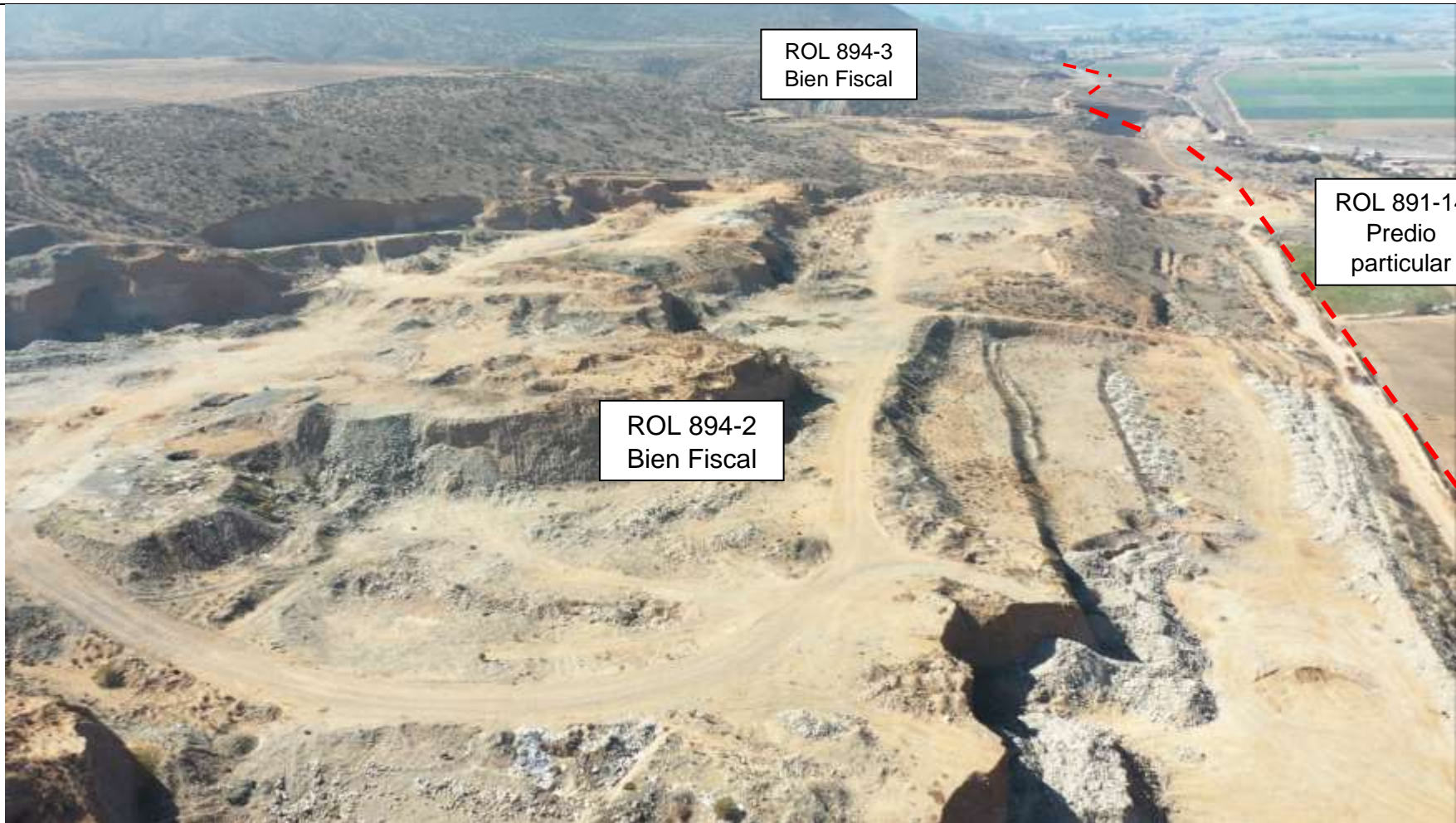
Vista hacia el oriente de propiedades fiscales en explotación sin autorización. Sector La Compañía Alta.
