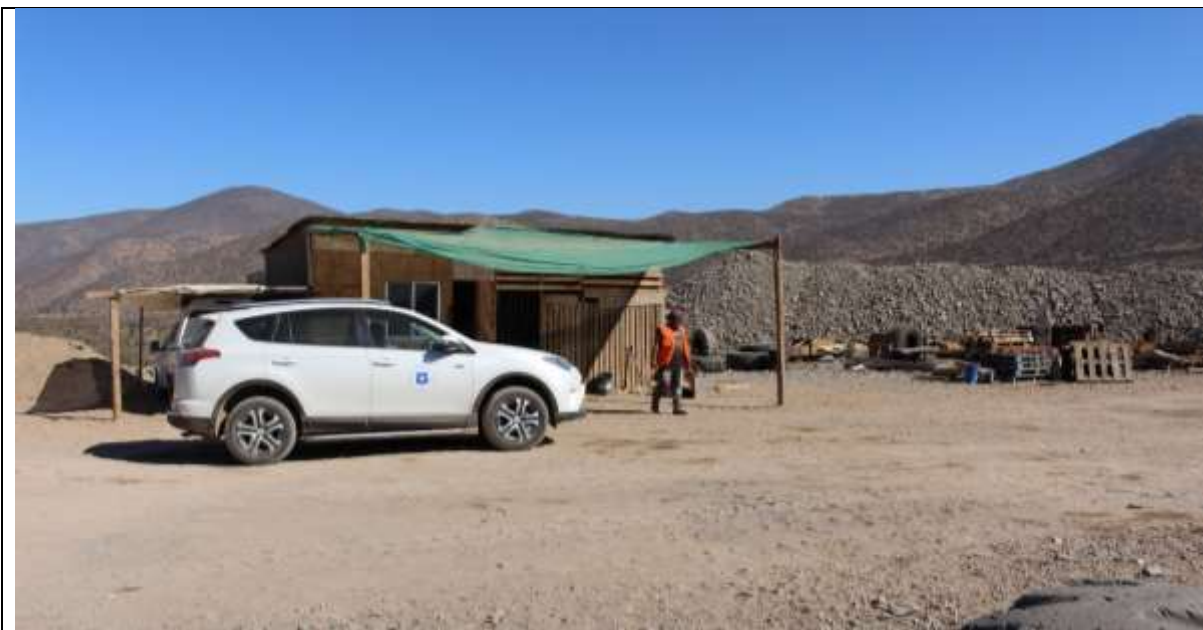
Fotografía N° 1. Registro capturado en visita a terreno de fecha 14 de mayo de 2021 evidenciando una construcción ligera no informada en el expediente asociado al permiso de extracción mediante decreto N° 555, de 2020, a la empresa Áridos Santa Gracia Limitada.
