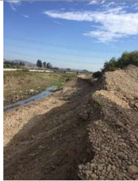
Fotografía N° 6. Acopio de áridos sector aguas arriba Puente Altovalsol.
