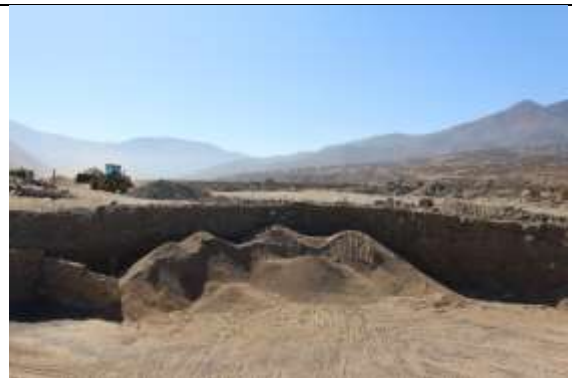
Fotografía N° 16. Extracción empresa Áridos Santa Gracia sin pago de derechos.
