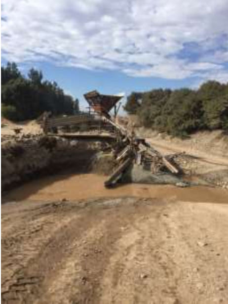
Fotografía N° 7. Procesamiento de áridos sector aguas arriba Puente Altovalsol.
