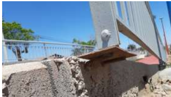
Fotografía N° 21 – 25/07/19: Barandas metálicas instaladas al costado del canal de La Pampa en el tramo N° 1, entre las calles Seminario y los Perales se colocaron sobre fierros inmersos directamente a la carpeta de hormigón.
