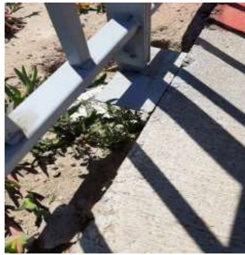
Fotografía N° 20 – 25/07/19: Barandas metálicas instaladas al costado del canal de La Pampa en el tramo N° 1, entre las calles Seminario y Los Perales se colocaron sobre fierros inmersos directamente a la carpeta de hormigón.
