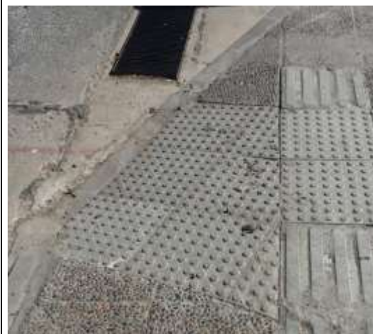
Fotografía N° 9 – 25/07/19: Pavimento de alerta incorporado en el pavimento de la rampa.
