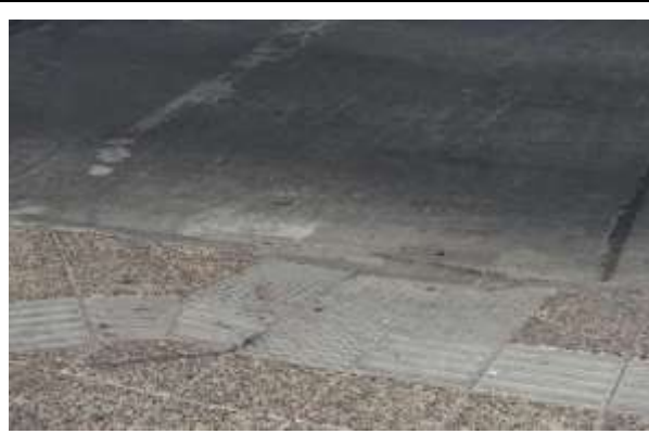
Fotografía N° 8 – 25/07/19: Pavimento de alerta incorporado en el pavimento de la rampa.
