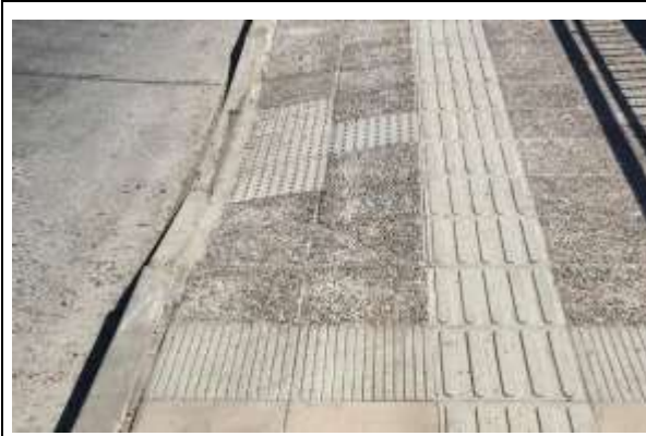
Fotografía N° 7 – 25/07/19: Pavimento de alerta incorporado en el pavimento de la rampa.
