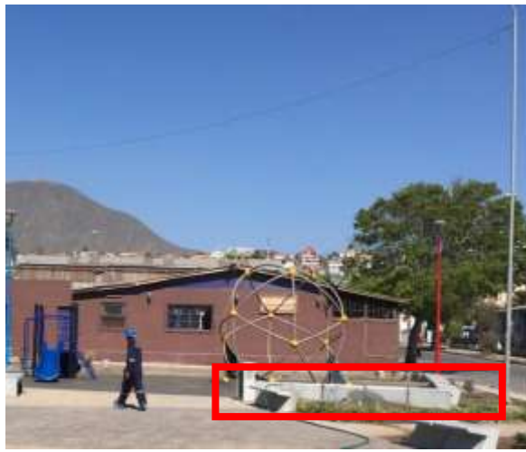
Fotografía N° 19 – 25/07/19: Instalación de escaños de hormigón aislados al costado del juego infantil cuerdas Cosmos 03 Urban Play en la plaza nororiente Humberto Valenzuela.
