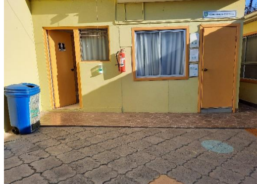
Fotografía N° 10, sala de convivencia escolar.
