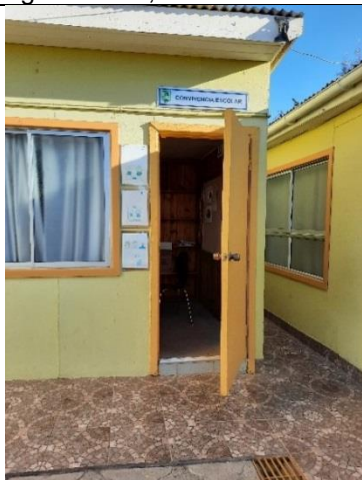
Fotografía N° 11, sala de convivencia escolar.
