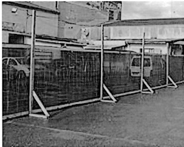
b) Cierres provisionales malla Raschel H= 2,00 M.
