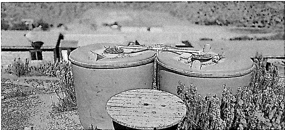
Ilustración 9 Estanques comunitarios, EMR El Chay Bajo
