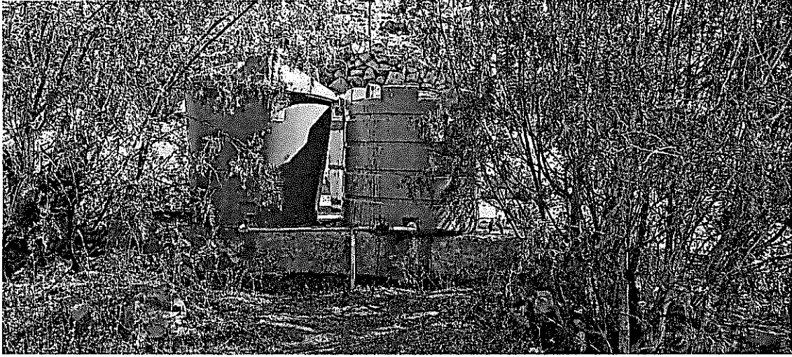
Ilustración 2 Estanques existentes sobre loza, EMR La Laja
