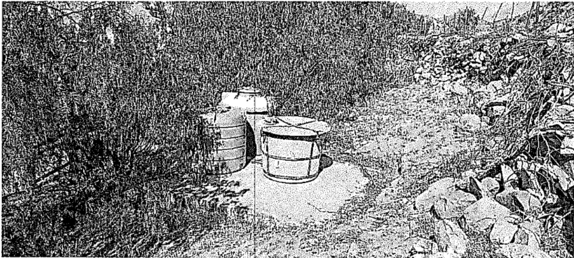
Ilustración 4 Estancques existentes sobre losa, vista superior de losa, EMR La Laja
