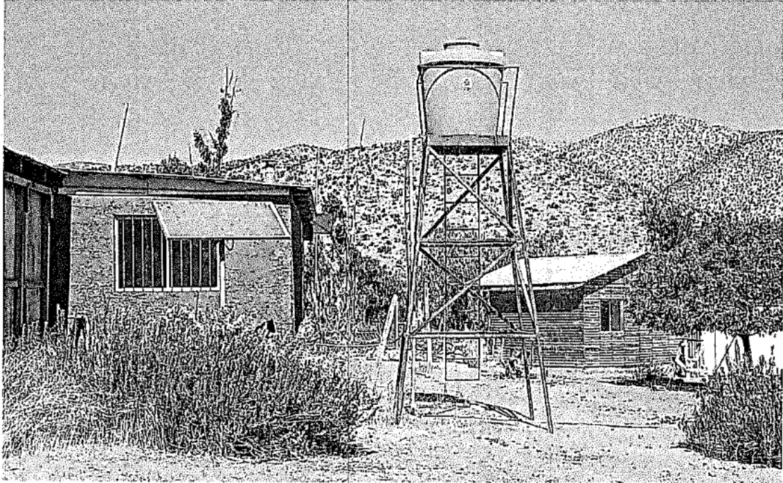
Ilustración 15 Estanque de Agua Potable de Sede Social, EMR El Chay Alto
