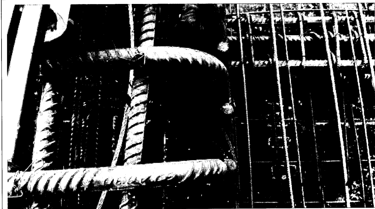
Fotografía N° 2: Trabas con abertura de 45° aproximadamente.
