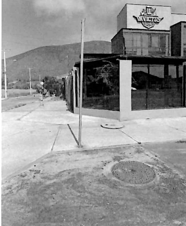
Eliminación de terraza provisoria B.N.U.P
