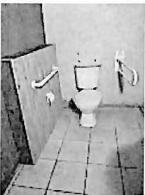
EXPANSION DE TABIQUE 02.jpg 202K
