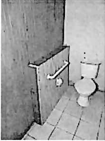
EXPANSION DE TABIQUE .jpg 176K
